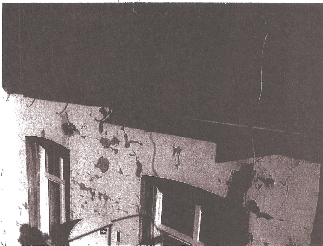
Odkrytki na elewacji zachodniej wykonano na gzymsie wieńczącym oraz nad oknami piętra.
