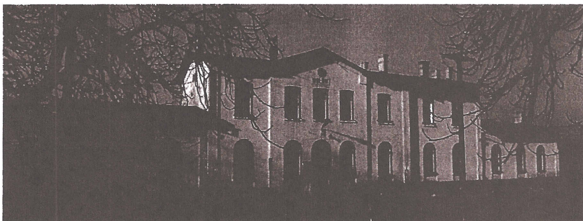
Elewacja wschodnia – stan w lutym 2014 r.
