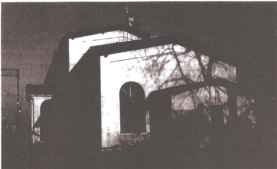
Elewacja południowa skrzydła południowego wraz z dobudówkami
