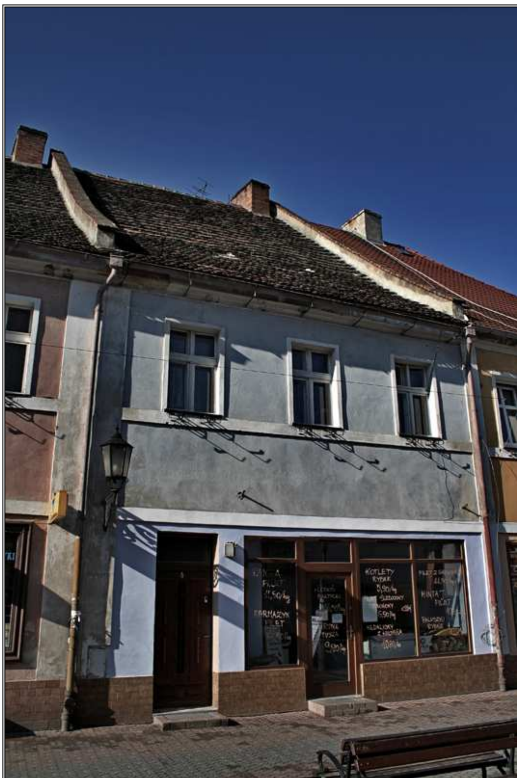
Fot. 15. Budynek przy ul. Piastów Śląskich 4.
