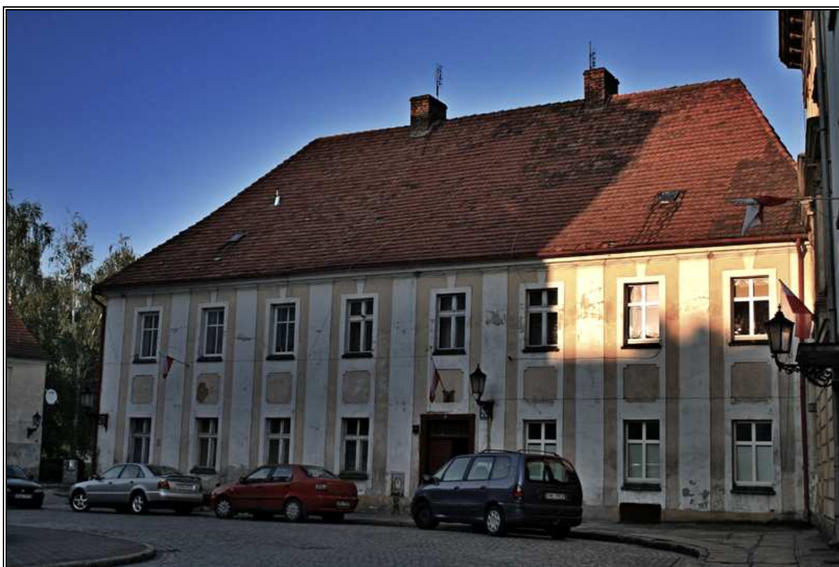
Fot. 18. Budynek mieszkalny przy ul. Wrocławskiej 20.
