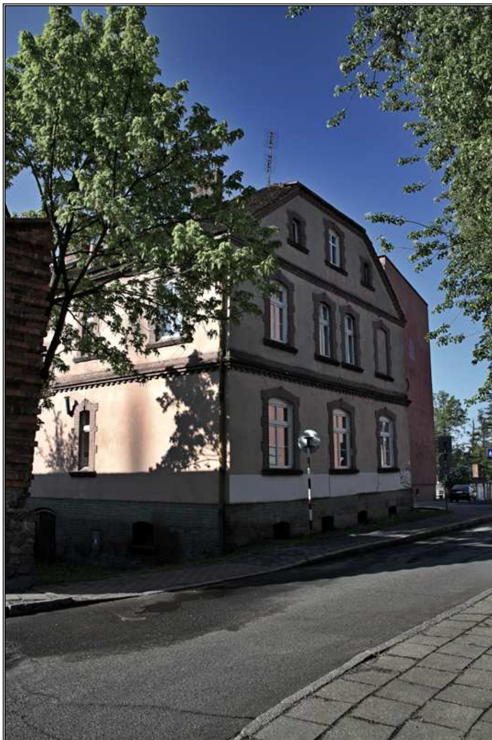
Fot. 11. Budynek przy ulicy Korzeniowskiego 5.
