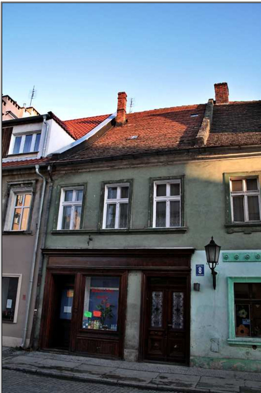
Fot. 19. Budynek przy ul. Wrocławskiej 8.
