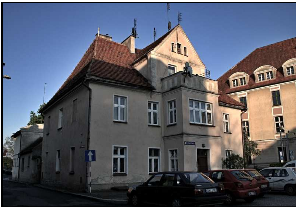
Fot. 12. Budynek przy Placu Piastowskim 1.
