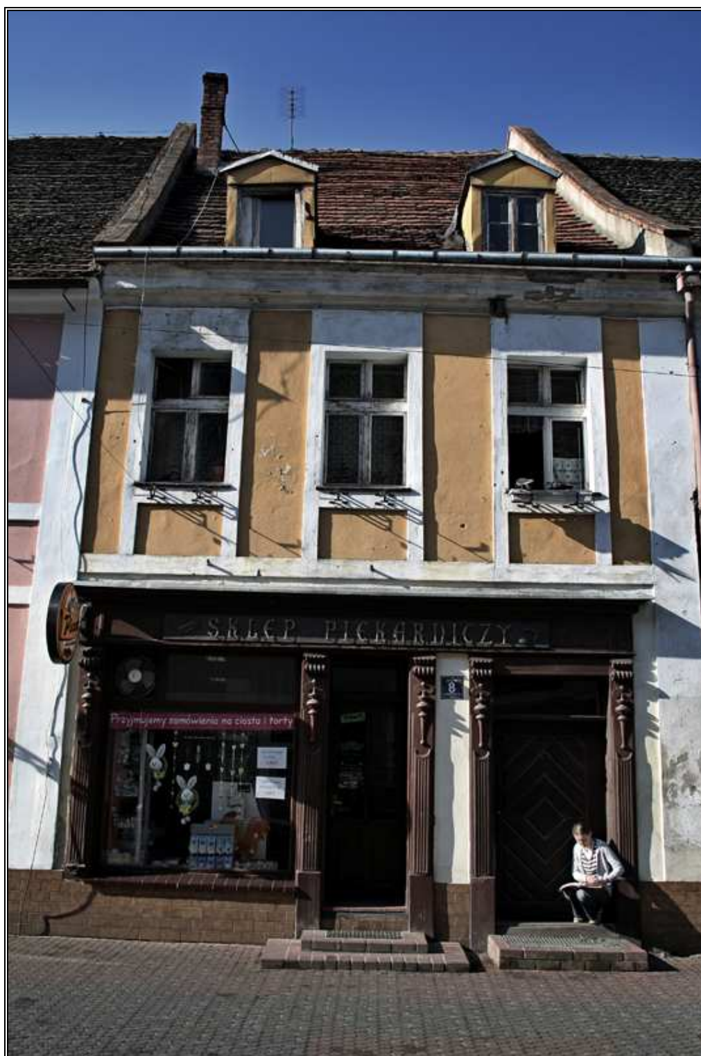
Fot. 16. Budynek przy ul. Piastów Śląskich 8.
