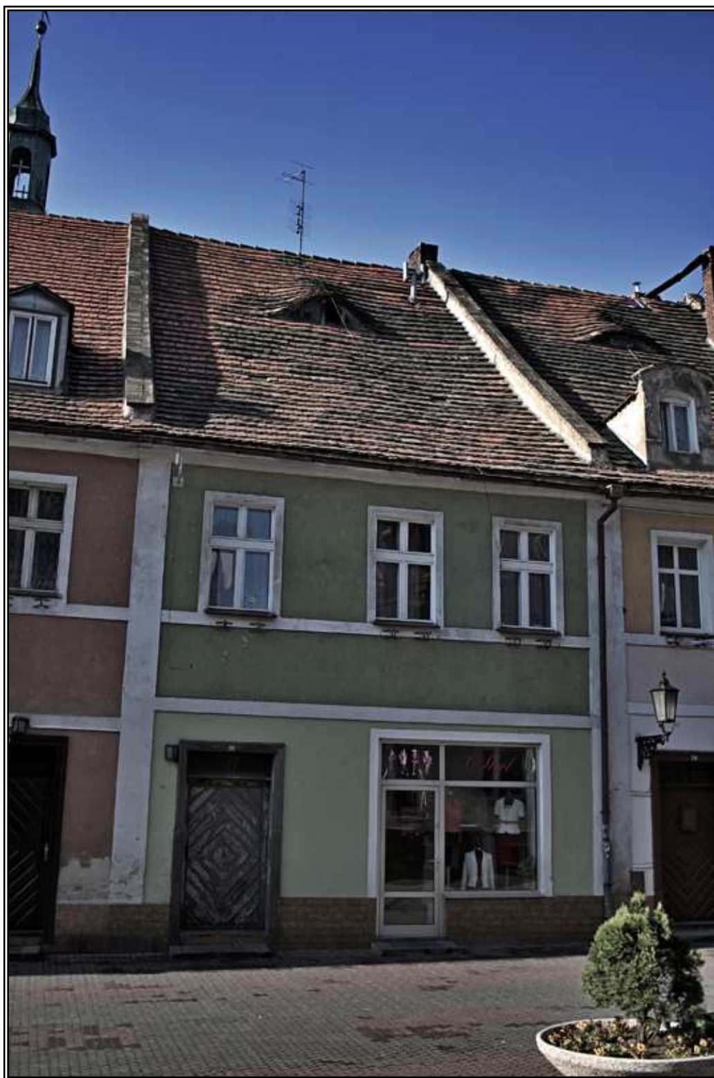
Fot. 14. Budynek przy ul. Piastów Śląskich 26.
