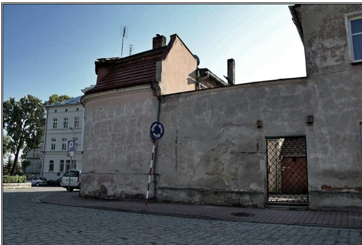
Fot. 20 i 21 Budynek przy Placu Sobieskiego 9.
