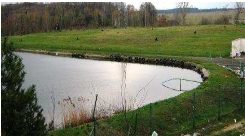
Rys.6. Gminne składowisko odpadów – staw na odcieki i zrekultywowana kwatera „1”
